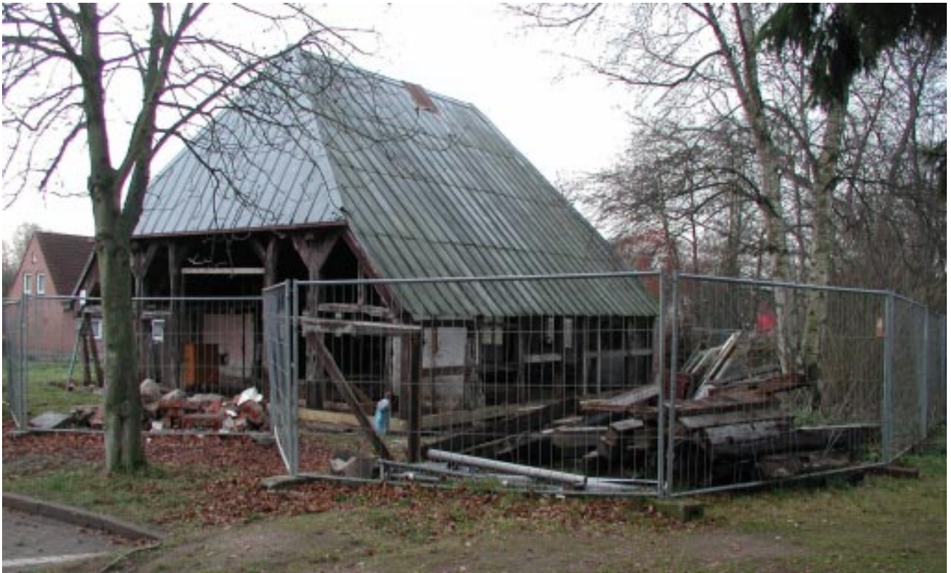
Die Röperkate mit „Durchblick“. Die Fachwerkfüllungen wurden entfernt. Das Gerippe steht noch.
